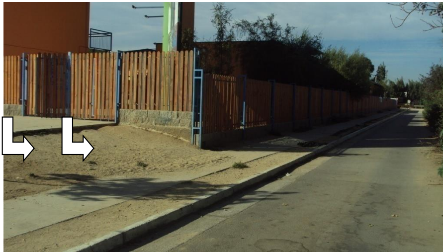
Evacuación externa general
